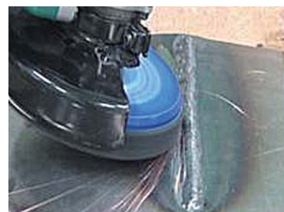
*odstraňovanie farebných defektov po zvaroch
